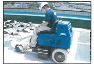
施工場所: 立体駐車場屋上 施工内容: ウレタン防水撤去
