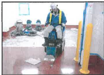
施工場所: 商品倉庫 施工内容: 硬質ウレタン撤去
