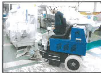
施工場所: 精密工場 施工内容: 長尺シート撤去
