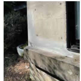
外壁の補修にも
