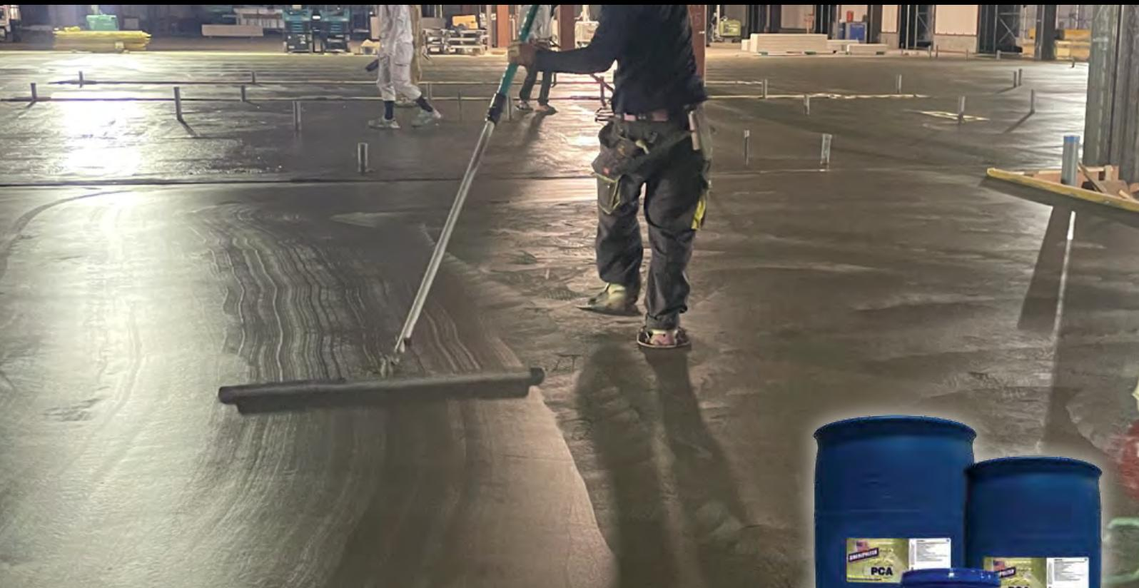
表面に膜を作らない、浸透性のコンクリート養生剤。
